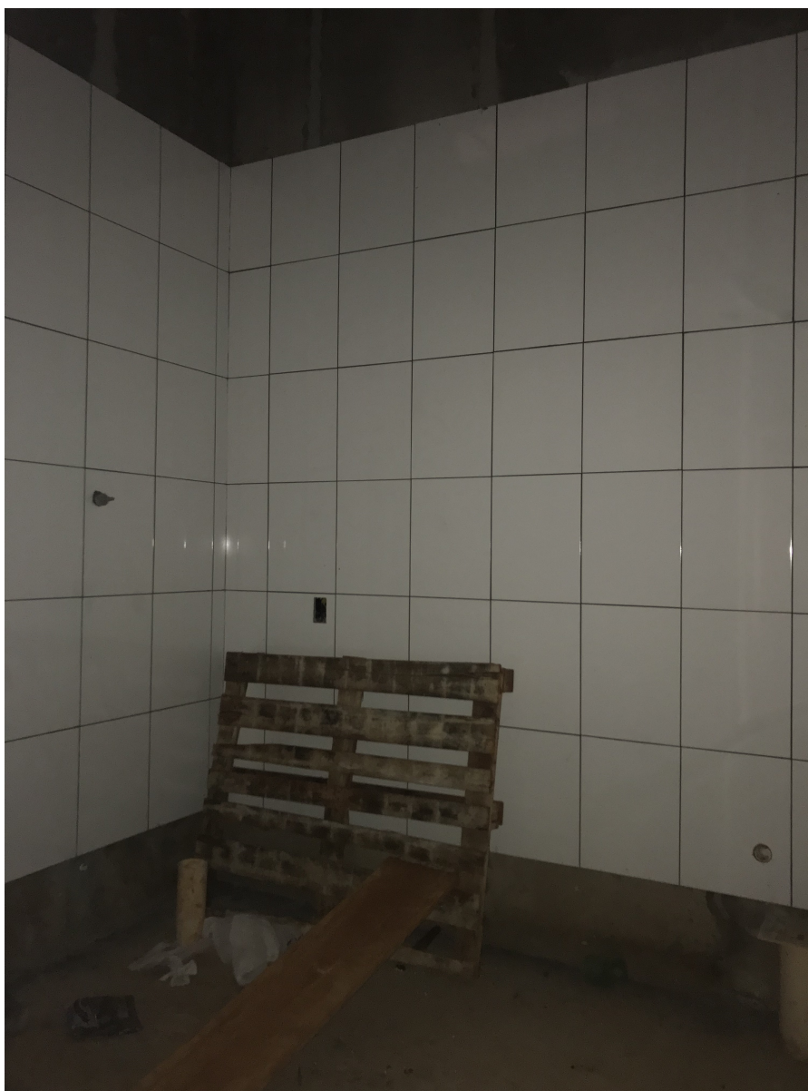
FIGURA 12 – SANITÁRIO PÚBLICO MASCULINO
