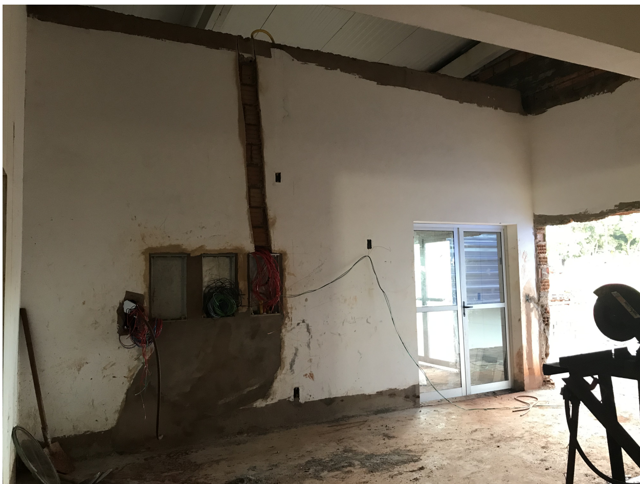
FOTO 16 – HALL DE DISTRIBUIÇÃO
