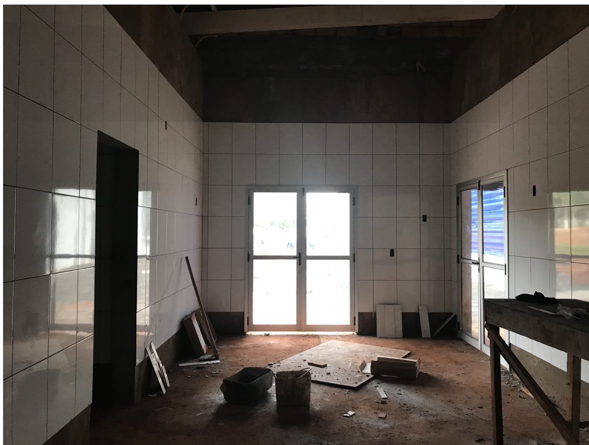
FIGURA 18 – HALL DE SERVIÇO
