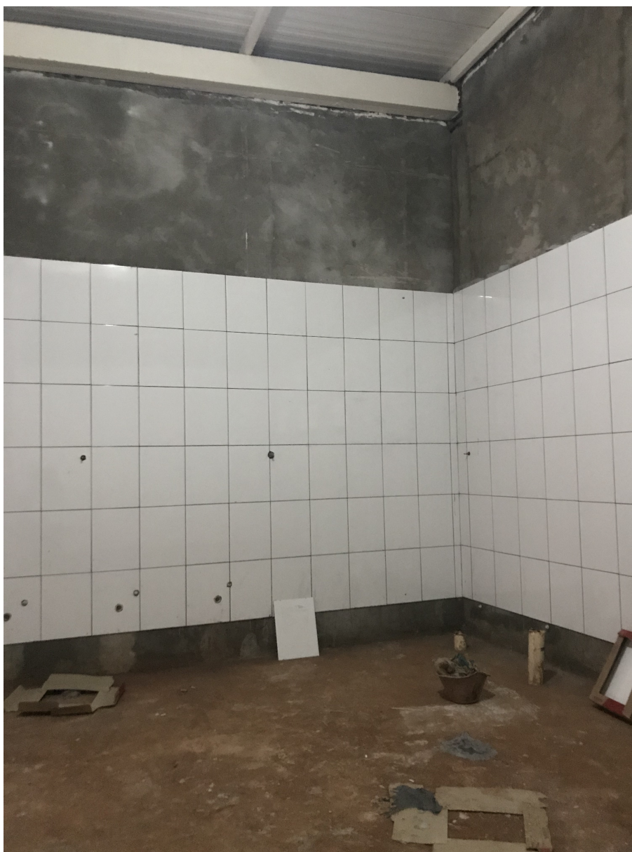
FIGURA 05 – SANITÁRIO PÚBLICO FEMININO
